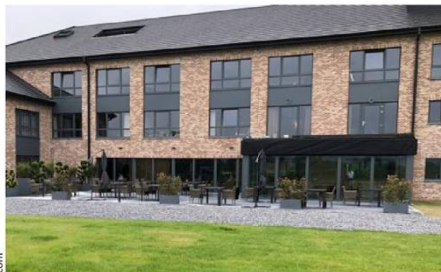
La Commune de Frasnes a facilité l'arrivée du « Jardin Intérieur ».
