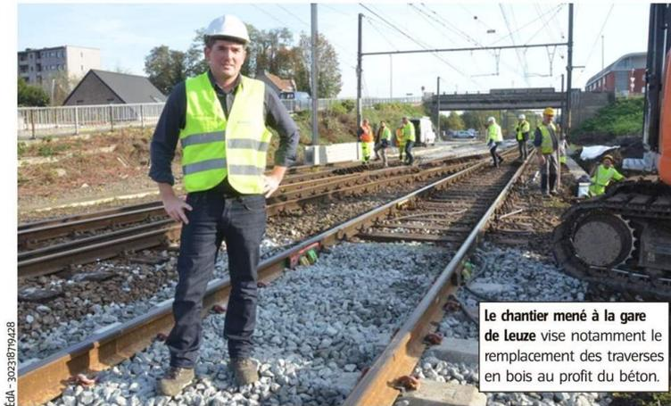
Le chantier mené à la gare de Leuze vise notamment le remplacement des traverses en bois au profit du béton.
