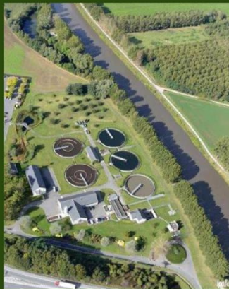
Notre région comptait l'an passé 47 stations. Celle de Froyennes traite les eaux usées de 40 000 habitants.
