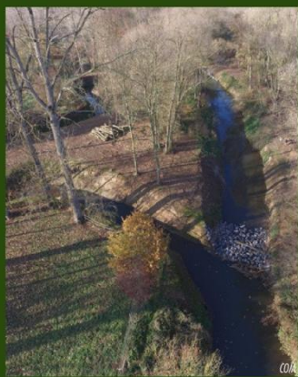
Environ 100 000 € ont été nécessaires pour rouvrir et aménager ce méandre.
