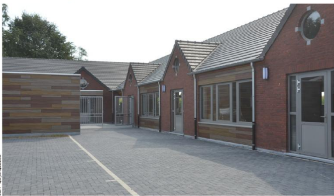
La « nouvelle » école communale, fraîchement rénovée et agrandie, est prête pour le grand jour.
