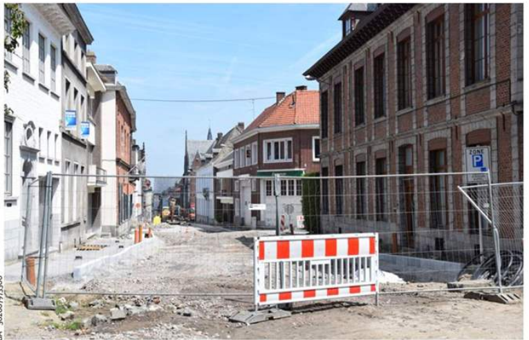
Si le chantier se poursuit un peu plus bas, plus aucun engin de chantier ne peut travailler en haut de la rue.
